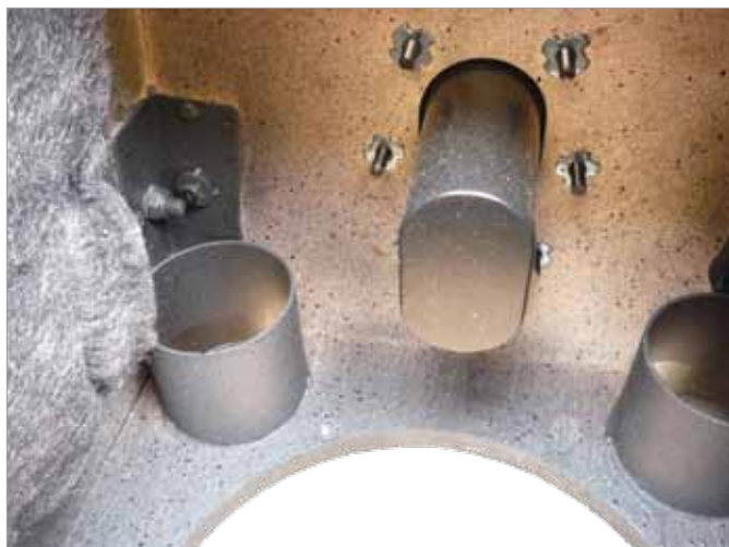
Obudowy wytłumiono niewielką ilością włókny, ścianki dodatkowo wzmacniają kątowniki, będące jednocześnie wspornikami dla gniazd uchwytów do podwieszania zestawów.
